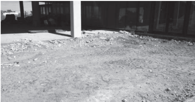
Demoliciones de contrapisos
