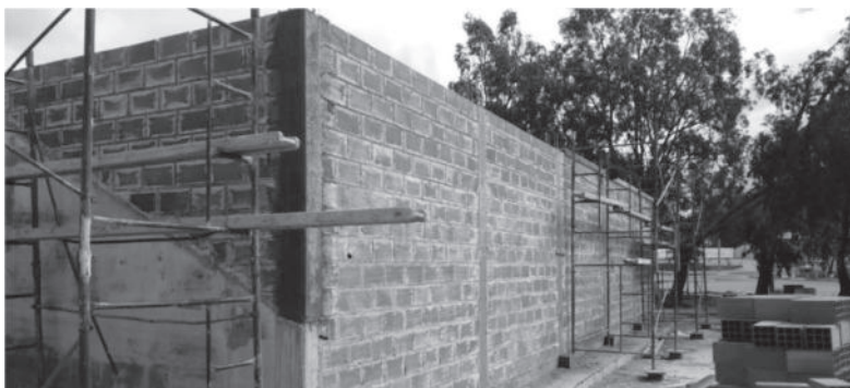
Cierres de Mamposterías en Anfiteatro
