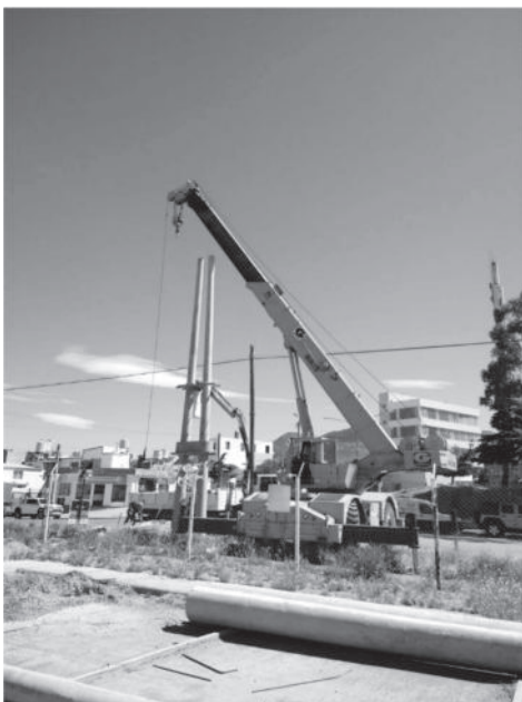
Armado de Columnas y Ménsulas Soportes
