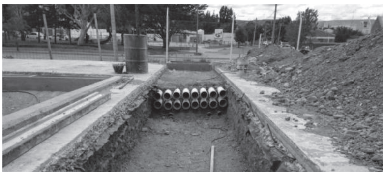
Ejecución de Cañeros y Acometidas Energía – Adicionales -
